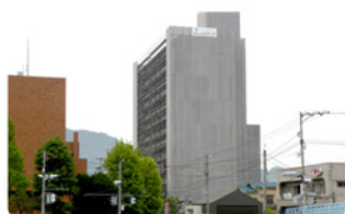
◎マンション大規模修繕工事
