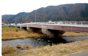
◎橋梁修繕工事
