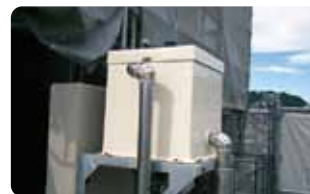
◎補給水槽塗装完了
